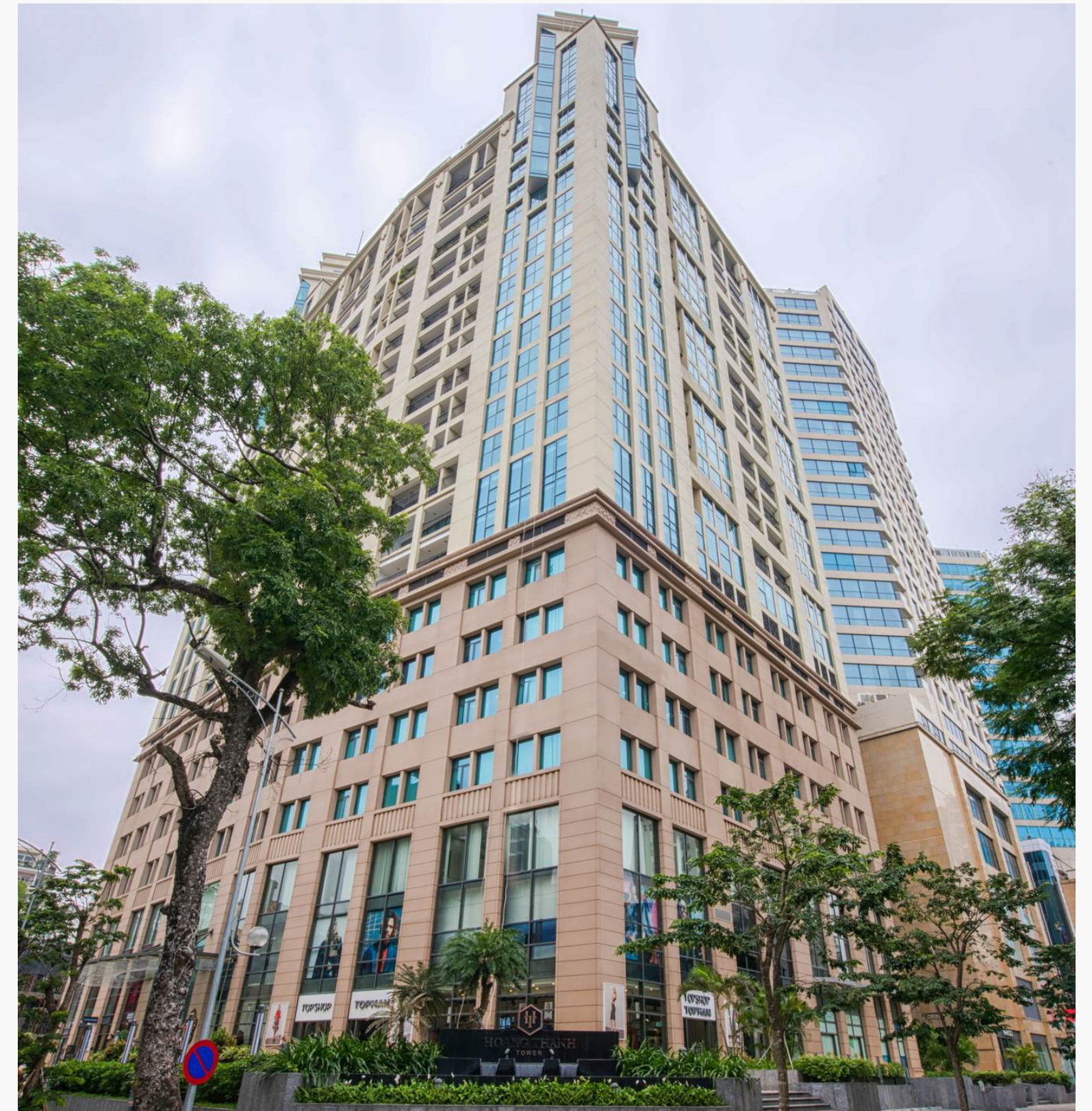
Dự án Hoàng Thành Tower
