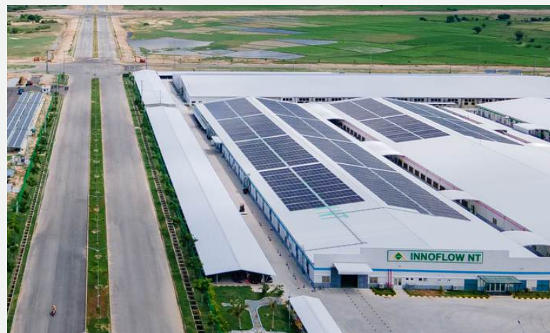
Nguồn điện mặt trời
