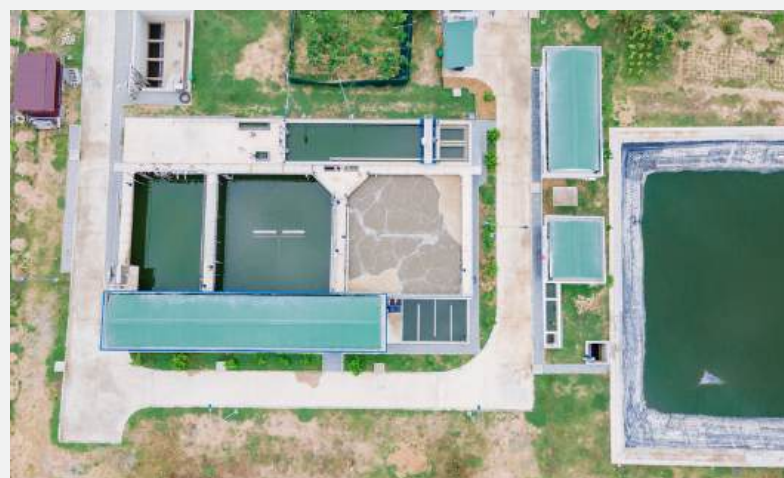
Bể xử lý nước thải
