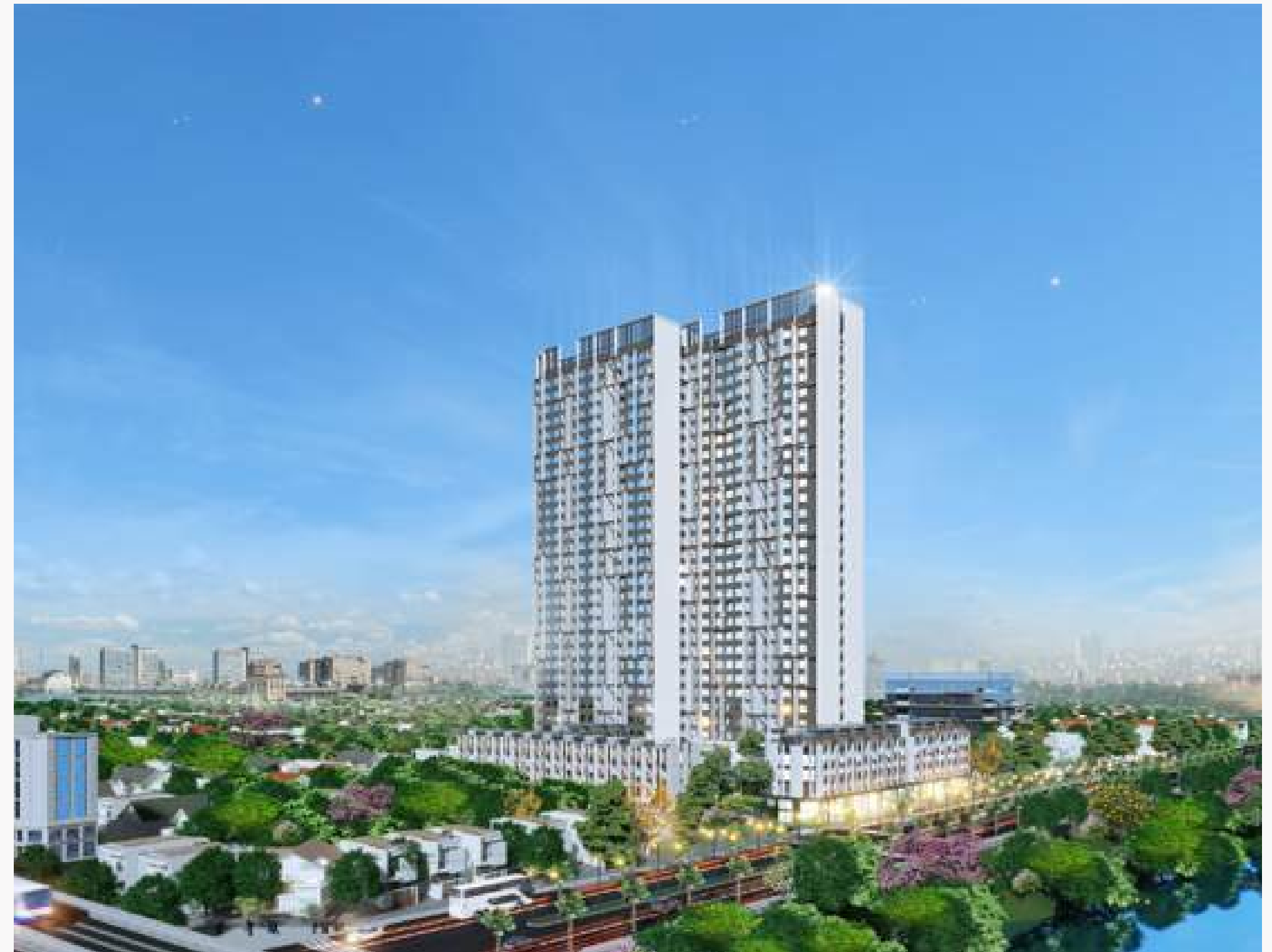
Dự án Hoàng Thành Pearl
