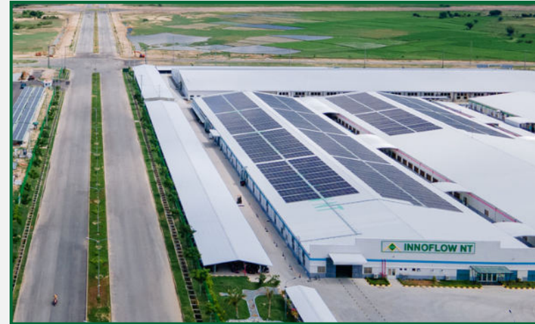
Nguồn điện mặt trời
