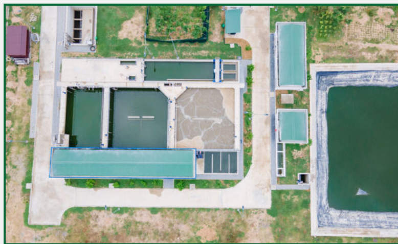
Bể xử lý nước thải
