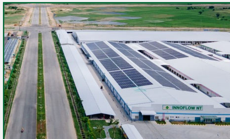
Nguồn điện mặt trời
