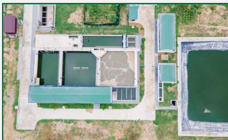
Bể xử lý nước thải
