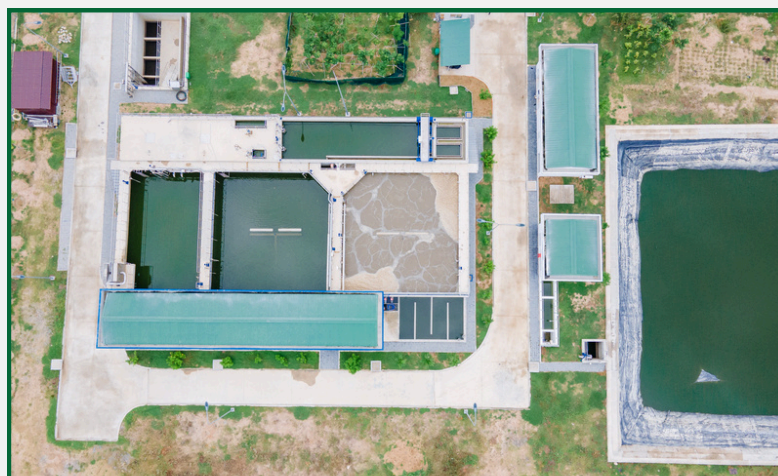
Bể xử lý nước thải
