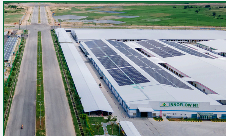
Nguồn điện mặt trời
