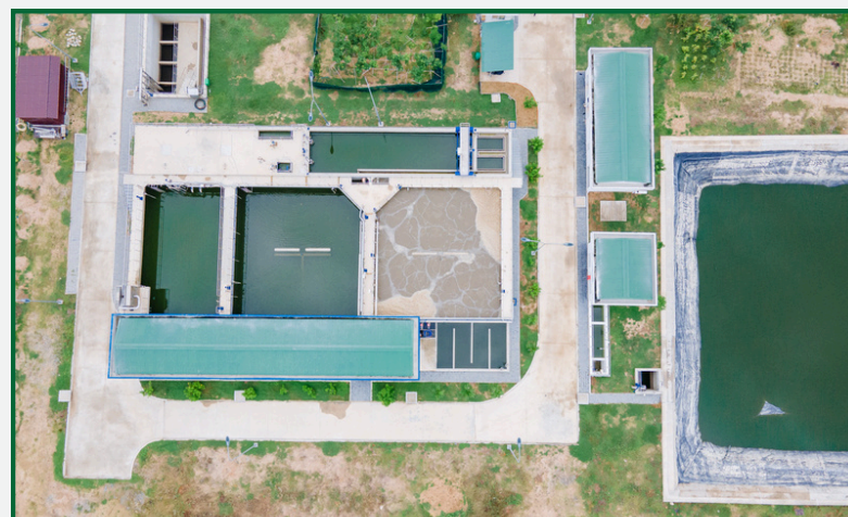
Bể xử lý nước thải
