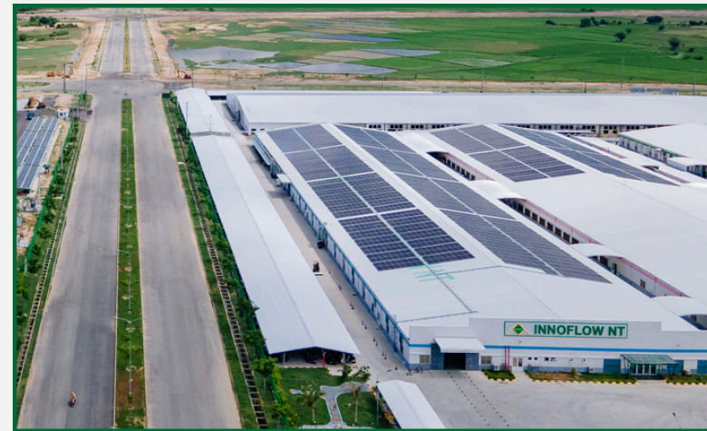
Nguồn điện mặt trời
