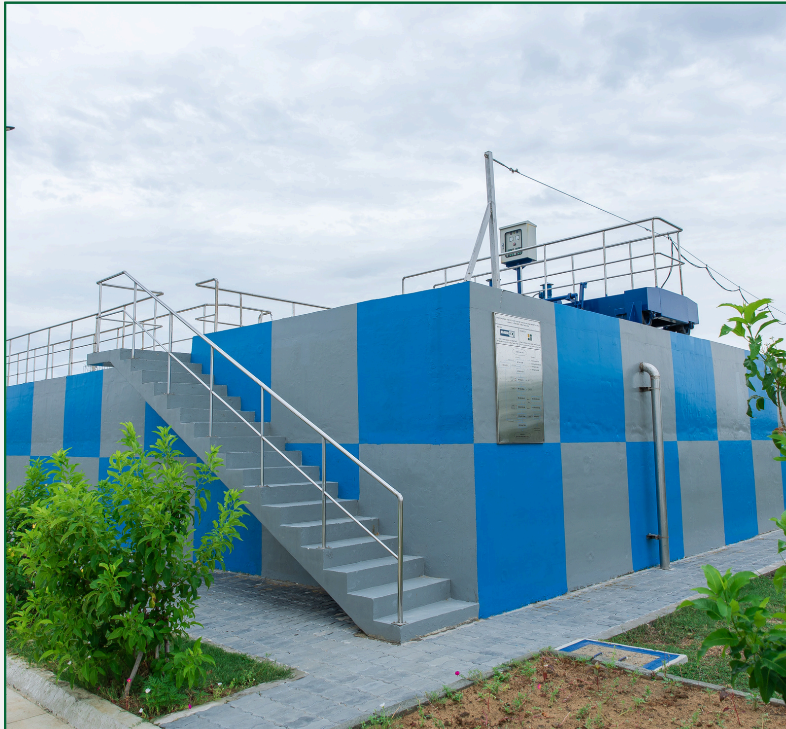
Hệ thống xử lý nước thải đang được vận hành căn cứ theo 306/GPMT-BTNMT
