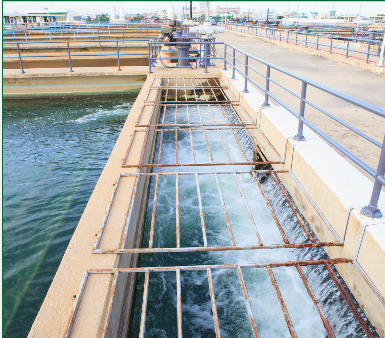
Nguồn cung cấp nước từ nhà máy nước sạch Nông thôn
