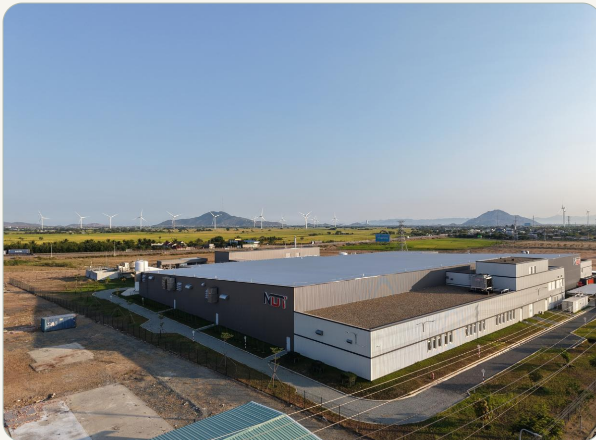
Dự án Nhà máy Điện Nhiệt Ninh Thuận với tổng mức đầu tư ~1,200 tỷ (hai giai đoạn) đã đi vào hoạt động từ năm 2024
