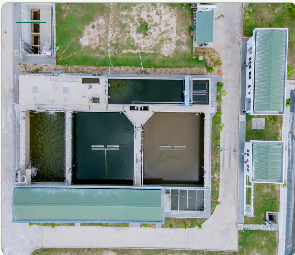
Hình ảnh flycam trạm xử lý nước thải Module 01
